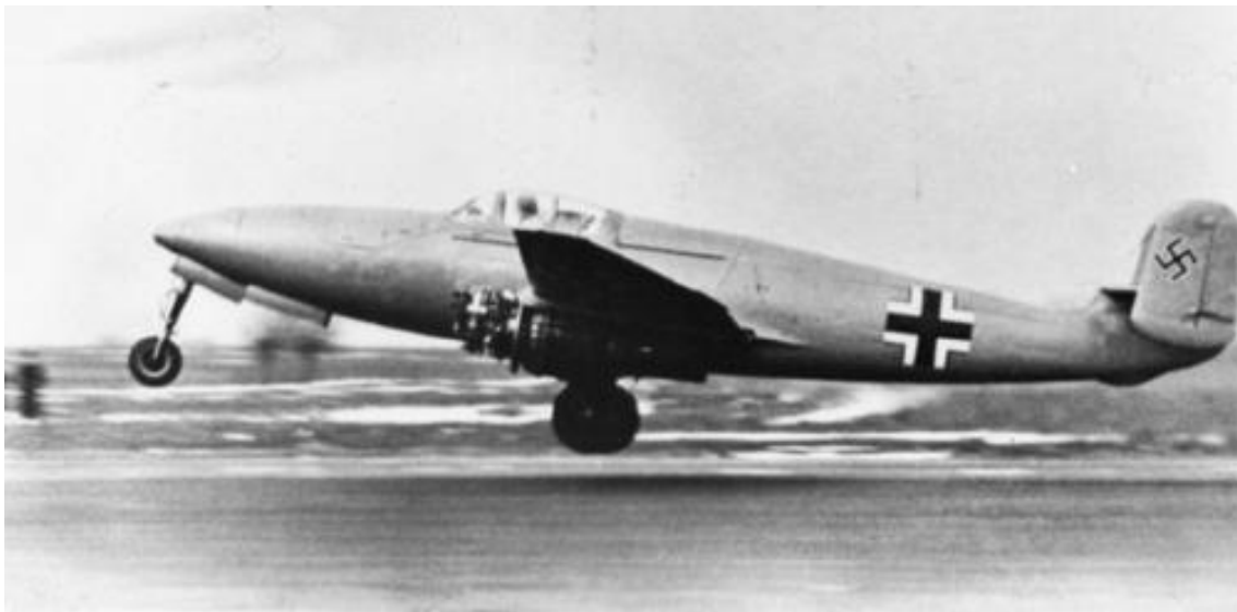
První let He 280 V1 s proud. motory He S8 A dne 2. dubna 1941. Motory jsou pro lepší odvedení pr sak paliva jezt nezakryté.
